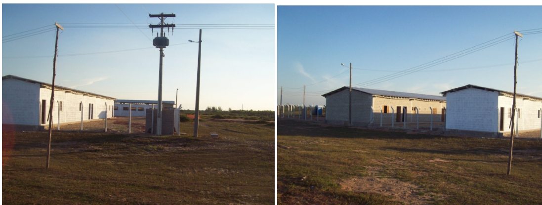
Figura 5. Área a ser utilizada com canteiro de obras
